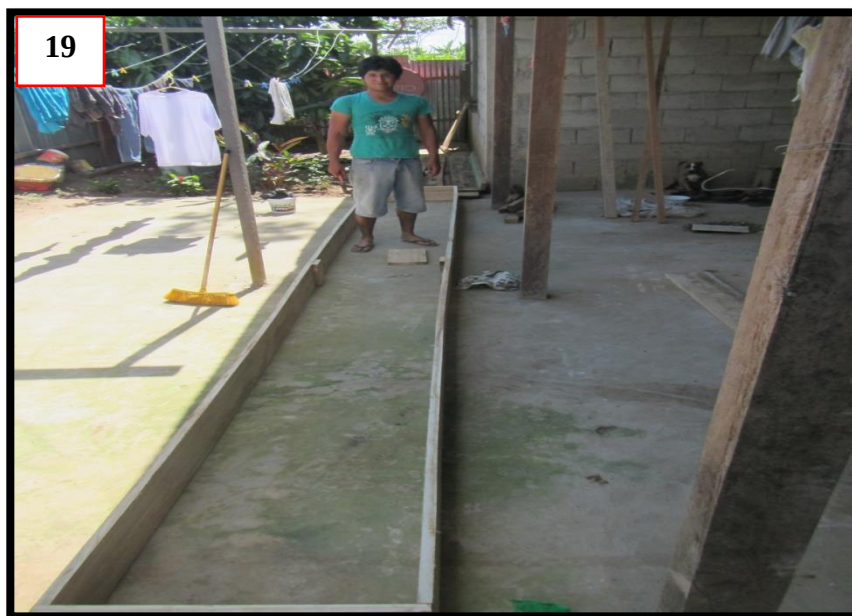
Fotografía 19: Perímetro de la cama de propagación vegetativa culminada
